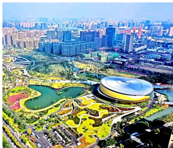
图1 杭州运河亚运公园实景图(图片来源: https://sports.sohu.com/a/516406879_99964967 )
